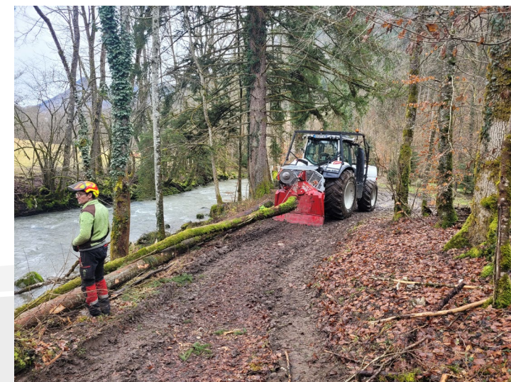
Interventions sur les boisements de berges – Le Brevon
