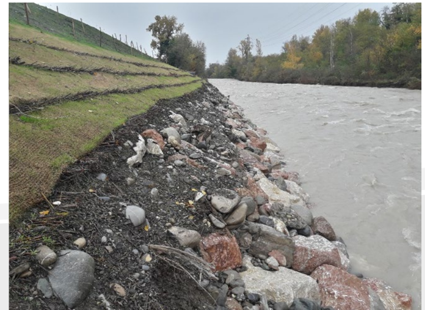
Berge Basse Dranse après traitement des invasives
