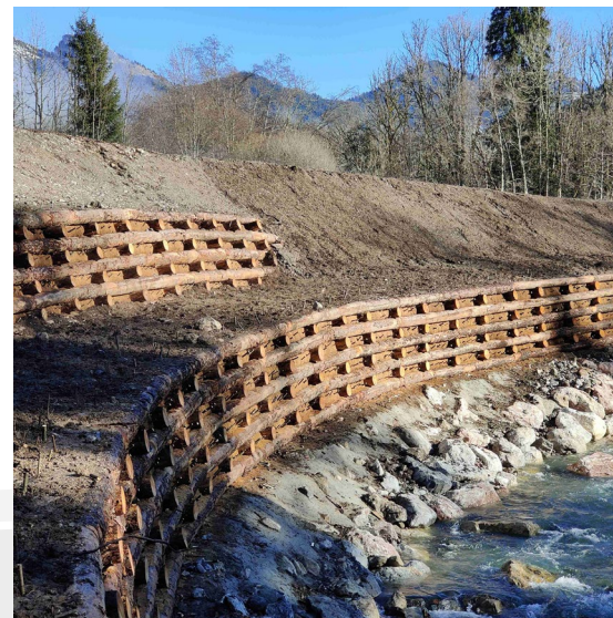
Richebourg : protection mixte par enrochement et caissons végétalisés
